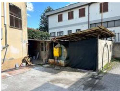
magazzino sgombero con adiacente tettoia
