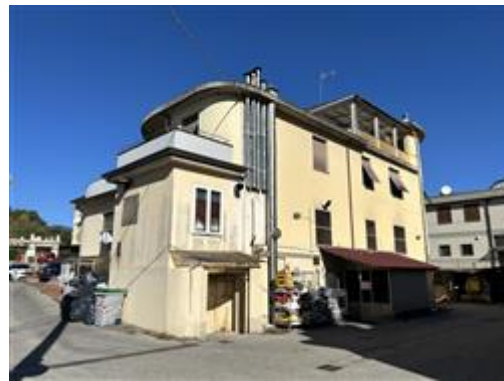
prospetto posteriore/tettoia da demolire
