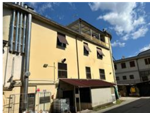
tettoia della prevista demolizione
